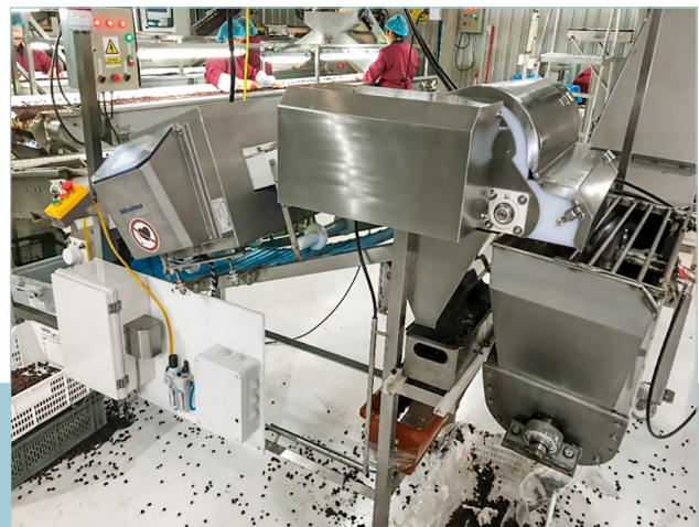
Todos los productos rechazados se eliminan del flujo de productos mediante la trampilla de desvío de dos vías
