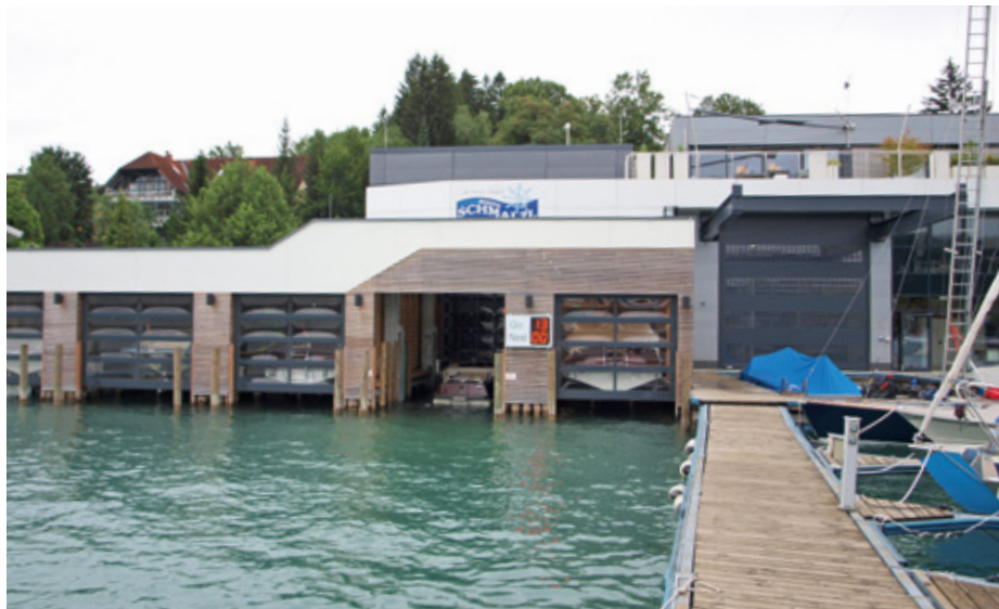
Das neue Bootshaus der Marina Velden mit der Einfahrt in den am Festland errichteten BoatCube
