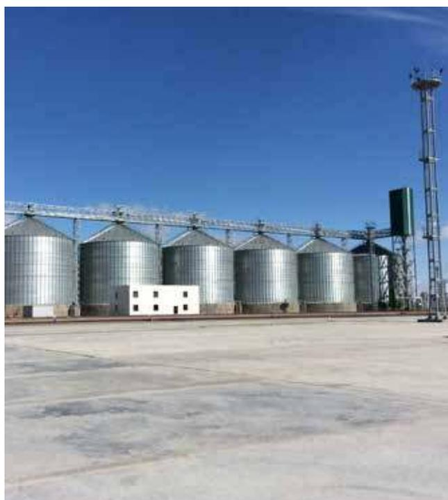
Nuestros silos con cuerpo cilíndrico y techo inclinado a 30° están destinados a almacenamiento de granos, semillas y otros productos. El equipo de ingeniería de Silos Córdoba diseña sus silos de acuerdo a distintas normativas para adaptarse a las necesidades de sus clientes, entre las que destacan las normas europeas EUROCODIGO y la estadounidense ANSI.
