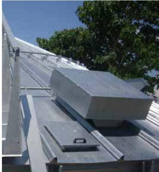
Los **extractores** son un complemento de la ventilación para ambientes tropicales o productos propicios a la condensación. Disponemos de ventiladores axiales equipados con hélice de plástico o de aluminio, incluyendo sus soportes específicos para cada tipo de extractor.
