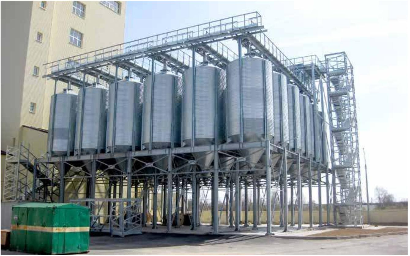
Diseñamos y fabricamos silos de expedición con **estructura soporte** para paso de camión o tren. Esta estructura está formada por perfiles de nudos rígidos laminados en doble T y construida en acero S275JR galvanizado en caliente. La altura estándar de la boca de salida del silo al suelo es de 4500 mm con posibilidad de adaptarnos a las necesidades del cliente.
