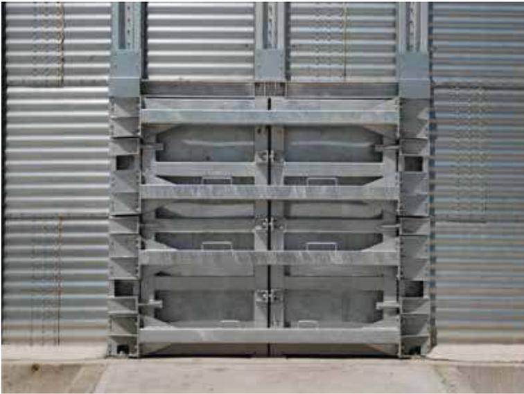
La **puerta bobcat** es idónea para silos de gran capacidad cuya descarga se hace a través de maquinaria ligera con pala tipo Bobcat que permite el vaciado del talud residual de producto. Está realizada con un marco rígido con pilares de transmisión de cargas al suelo y refuerzos horizontales.
