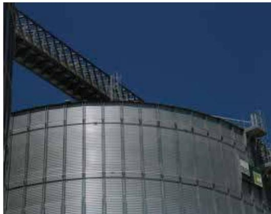
El **Wind-Ring** permite que el silo conserve su forma cilíndrica sin afectarle las cargas de viento dándole rigidez y seguridad. Dependiendo del diámetro y la altura del silo se pueden colocar en el techo o en la virola.
