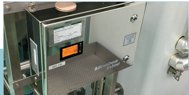
Las células de carga y los sistemas electrónicos de Minebea Intec ofrecen un pesaje fiable de recipientes de proceso
