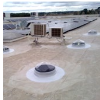
2- Cobertura Deck, revestimiento en manto pvc
